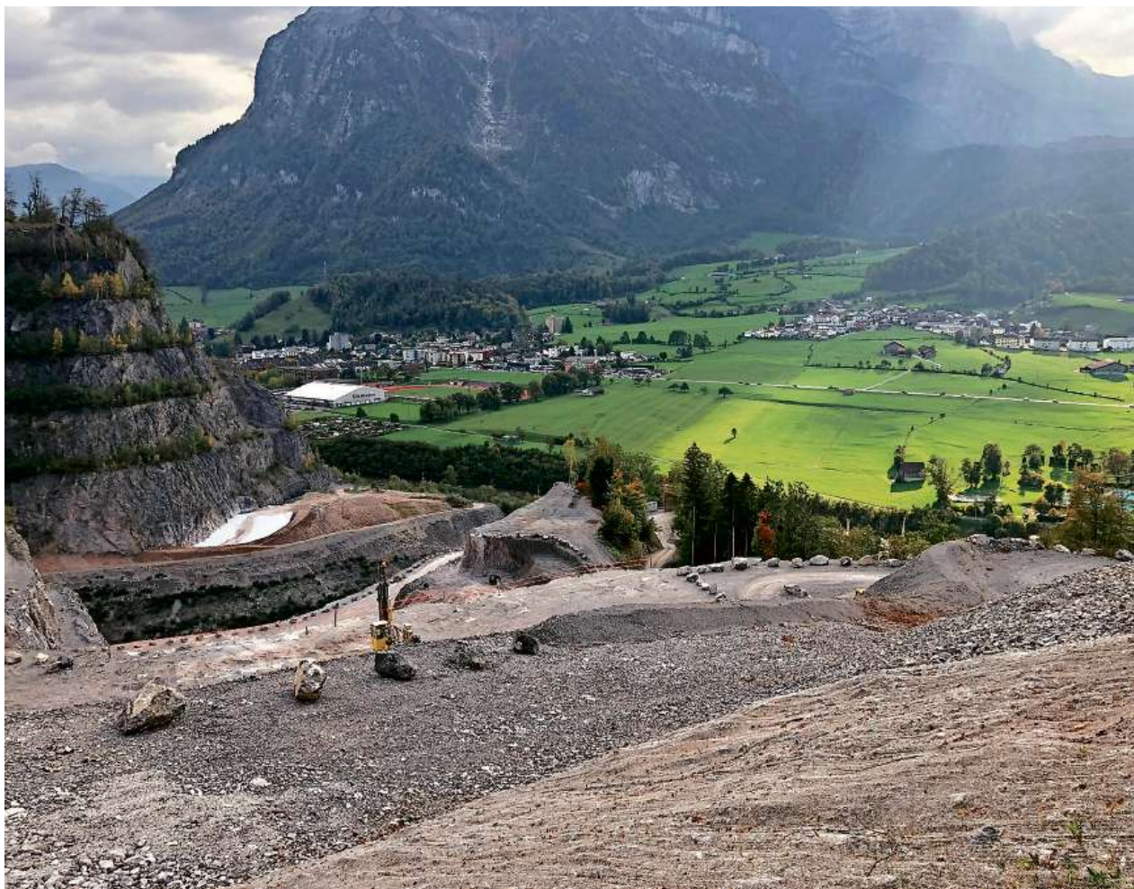
Loch im Berg: Die Kalkfabrik will ihr Abbaugebiet erweitern, weil sich die Kalkreserven zu Ende neigen.
