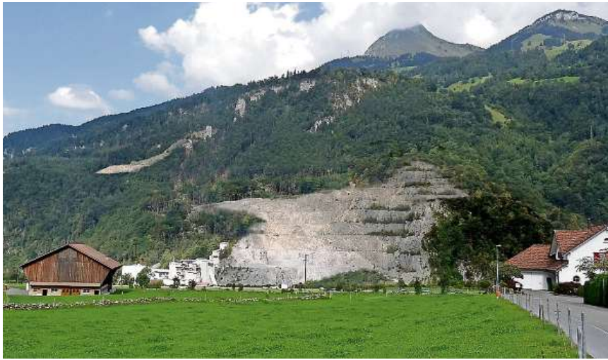
Nach zehn Jahren: Oben links am Berg wird der neue Abbau Gründen sichtbar, im Elggis rechts neben dem bisherigen Steinbruch ist der Hügel gekappt worden.
